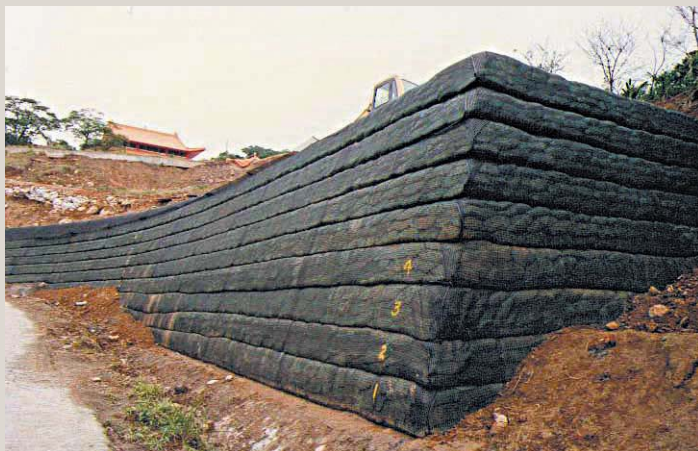
石籠擋土牆具有水土保持的功能。
