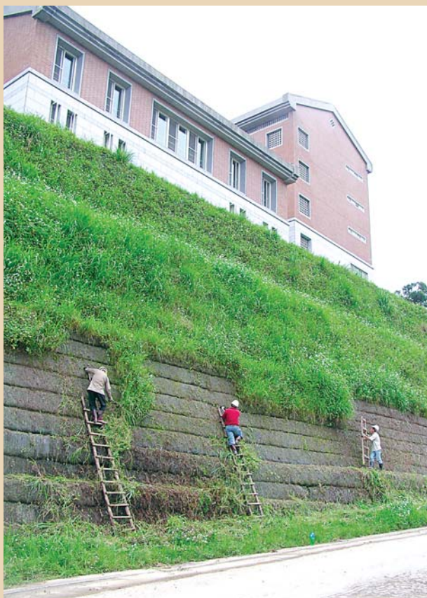
進行水土保持與邊坡工程時，以植栽原生植物為第一考量。
