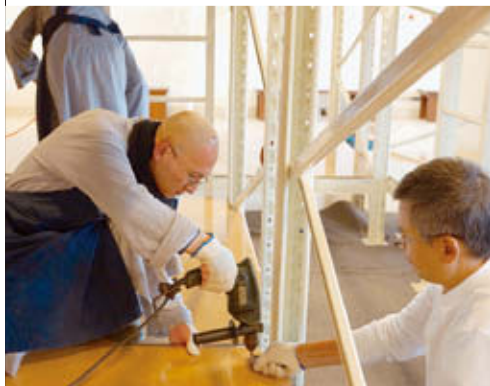
水陸法會圓滿當天，五百多位法師、義工同心協力參與普請，將園區恢復本來面目。
